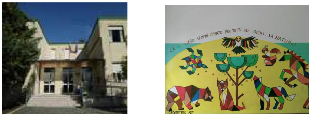
Figura 17: Scuola Primaria "Selvaiezzi" - Via Salvo d'Acquisto - 66100 Chieti Scalo (Ch)
